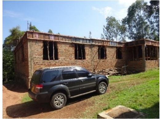
建設中の入院施設
